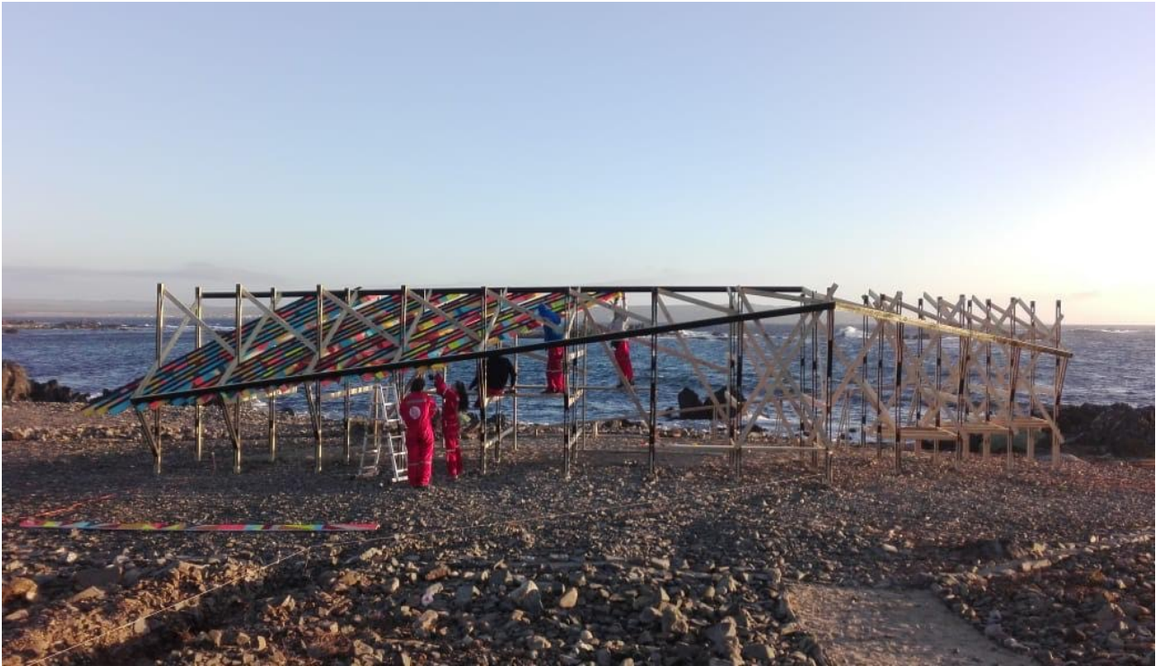
Figura 2. Corredor Litoral. (Travesía Caleta Chañaral de Aceituno, 2018. Pasillo de madera con techo de celosía, asientos integrados y un deflector de viento. La celosía está orientada a propósito hacia el norte, lo que permite que la luz del sol se filtre y proyecte patrones de color en el interior blanco. Situada a 20 metros de la marca de marea más alta, esta obra pública es fruto de la colaboración de 49 estudiantes y 5 profesores de los estudios de diseño de primer curso.
